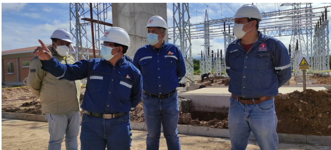
Foto de Archivo - AETN inspecciona obras en la Subestación Bermejo en Tarija
